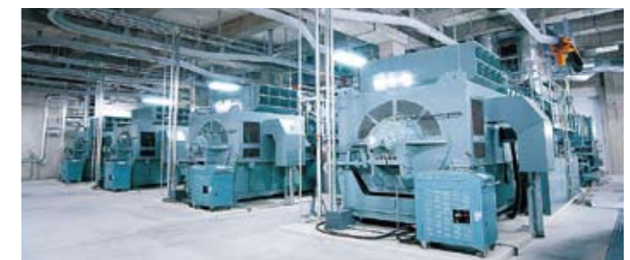
液晶工場では、コ・ジェネレーションシステムの導入により、クリーンなLNG(液化天然ガス)による自家発電を行っています。(CO 2 削減効果76,000t-CO 2 /年)
